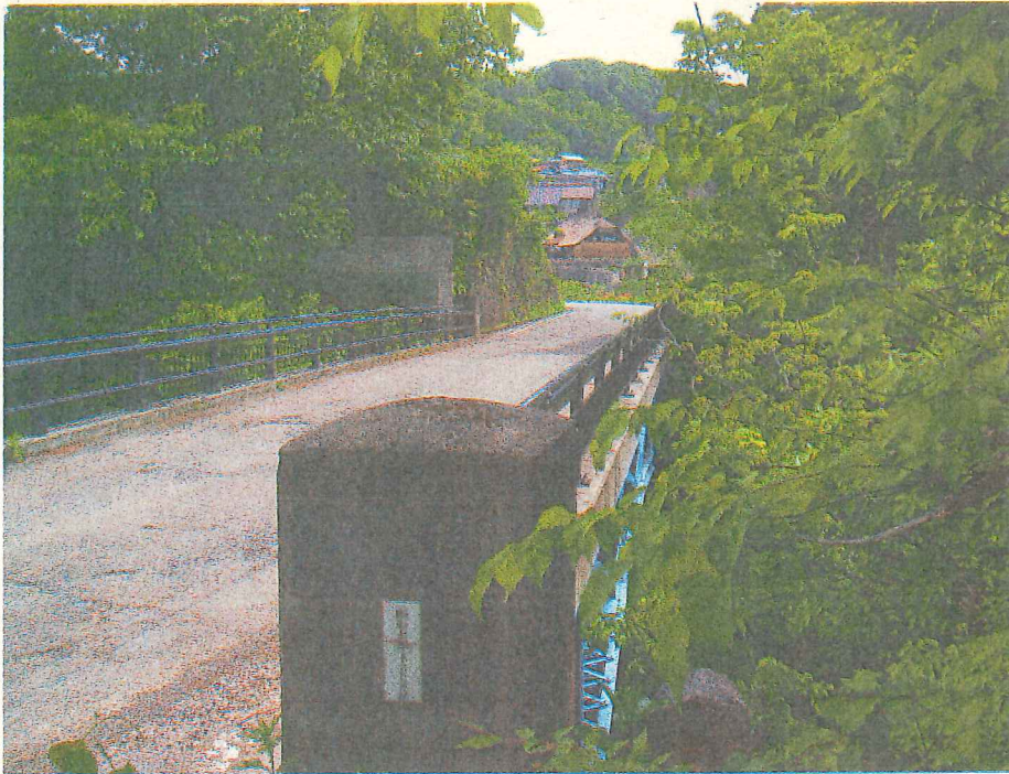
田麦川に架かる現在の田麦橋—自然写真家・斎藤政広 (2017年5月26日撮影)
