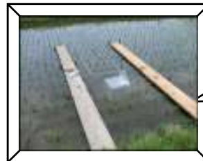
土壌が攪乱ないように足場を設置しました
