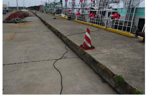
写真7 鼠ヶ関漁港岸壁の沈下
