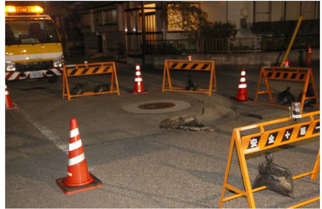
写真1 鶴岡市城北町の道路陥没
