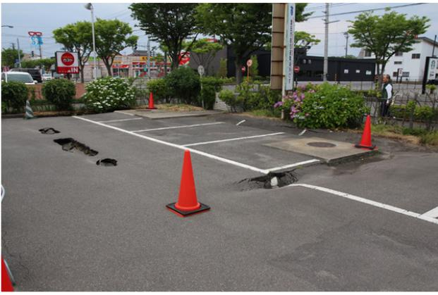
写真11 酒田市大町コミュニティセンター駐車場の陥没
